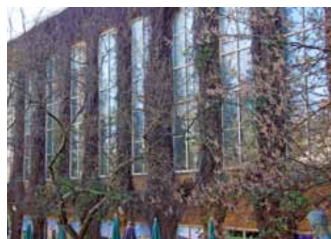
Swedbankhusets stora fönster värms upp med elslingor som är mycket energikrävande. Här gäller det att få en effektiv styrning så att uppvärmningen bara sker då det verkligen behövs.
